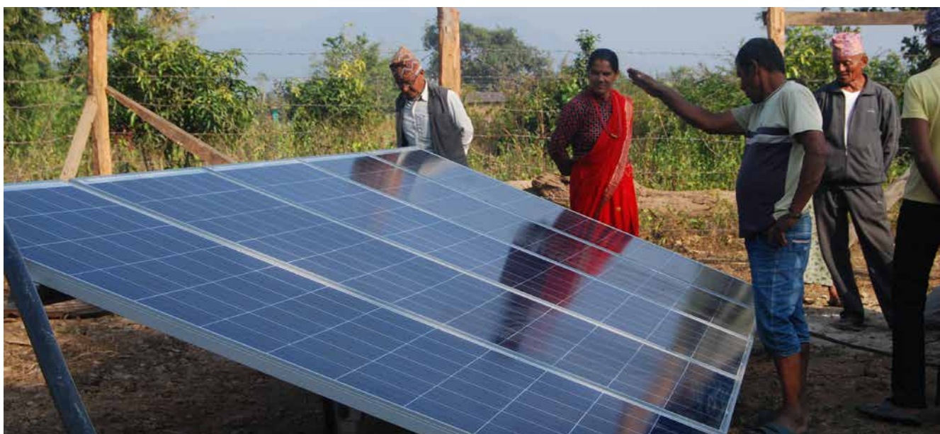
ภาพที่ 15: การติดตั้งระบบชลประทานพลังงานแสงอาทิตย์ในประเทศเนปาลเพื่อรวบรวมน้ำจากแม่น้ำไปยังบ่อซึ่งจะใช้สำหรับการชลประทานในช่วงฤดูแล้ง
