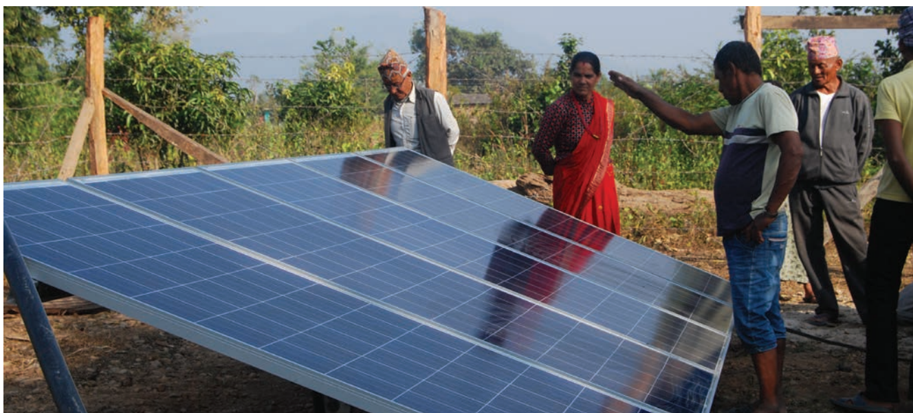
Figura 15: Instalasaun ba sistema irrigasaun hosi enerjia solár iha Nepal hodi halibur bee hosi mota tama mai kolan ne'ebé sei utiliza ba irrigasaun durante oras bailoro. Photo Kréditu: Shobha Manandhar
