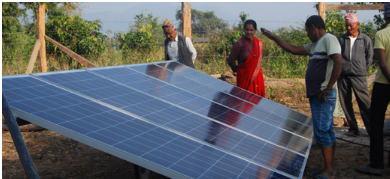
Рис. 15: Установка ирригационной системы на солнечных батареях в Непале для сбора воды из реки в пруд, который будет использоваться для орошения в засушливые сезоны. Автор фотографий: Шобха Манандхар
