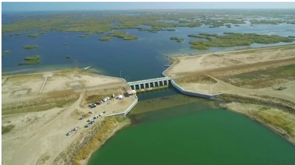
Рис.3.5 Плотина Северного Аральского моря
