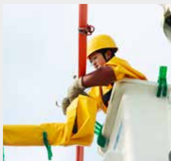
Mulheres engenheiras trabalhando em sistemas elétricos de alta tensão.
