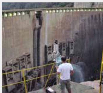
Tecnologias avançadas de engenharia com uso de escaneamento a laser para monitorar a barragem de Cahora Bassa, Moçambique, uma das maiores barragens do mundo.
