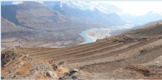
Terrazas construidas para estabilizar pendientes y limitar la erosión del suelo
